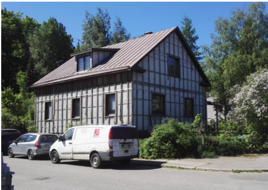
Kuva 9. Suunnittelualueella oleva rakennus kuvattuna Urheilukadun ja Maaherrankadun risteyksestä (kuva otettu 29.5.2018).
