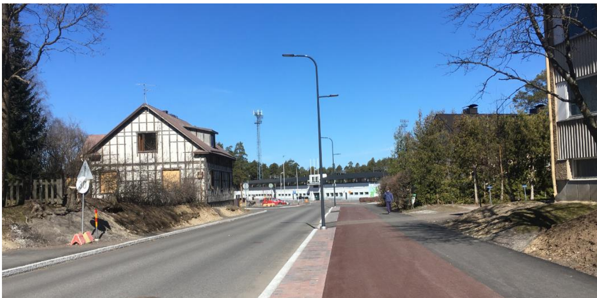
Kuva 12. Urheilukadun uusittu kevyen liikenteen väylä näkyy kuvassa oikealla.
