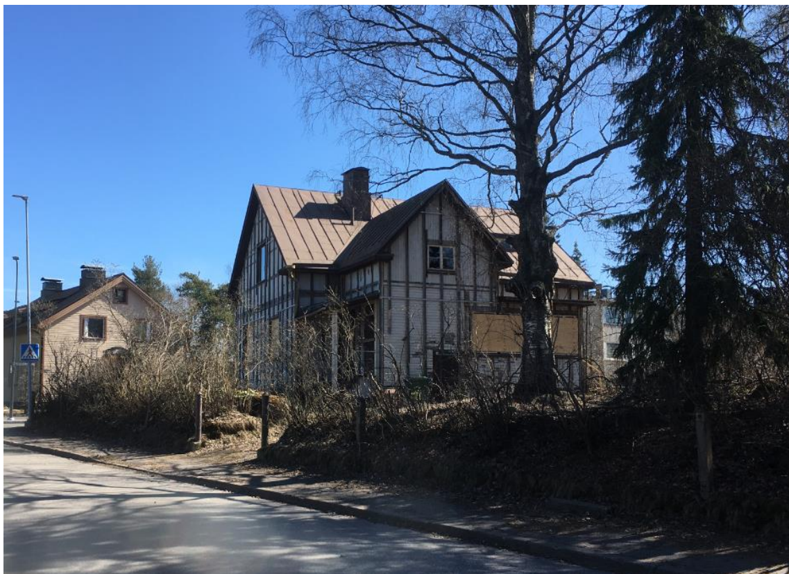
Kuva 10. Rakennuksen ikkunoita on rikottu ja piha-alueella on paljon roskaa. Kuva on otettu Maaherrankadulta.
